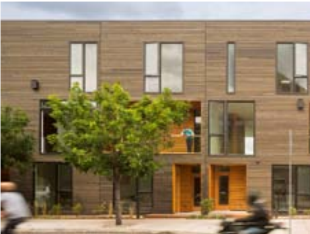
Spel binnen-buiten door grote en verbijzonderde ramen en terugliggende elementen in de gevel.
