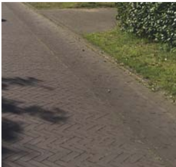
Brede goot voert water oppervlakkig af
