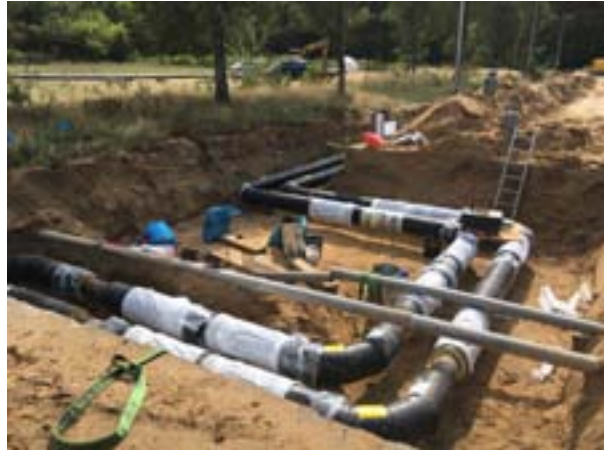
Aanleg primair warmtenet op het WFC
