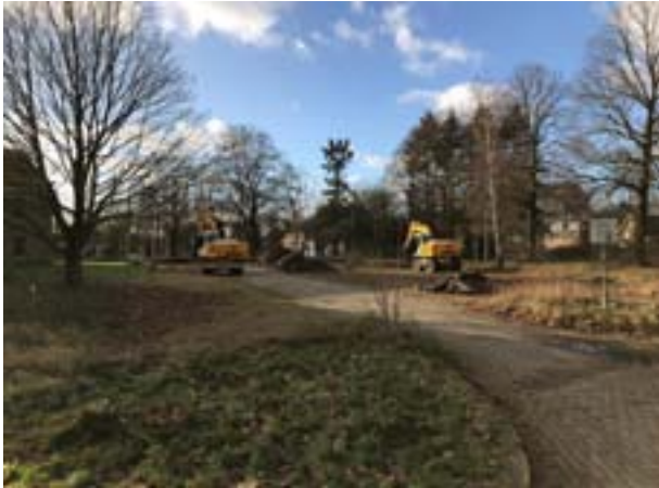
Werkzaamheden voor onderzoek niet gesprongen explosieven
