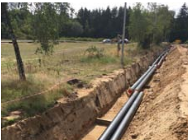
Hoofdleiding warmtenet langs oostelijke ontsluiting
