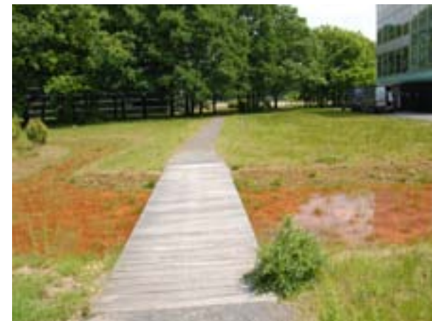
Laagtes ten behoeve van infiltratie regenwater
