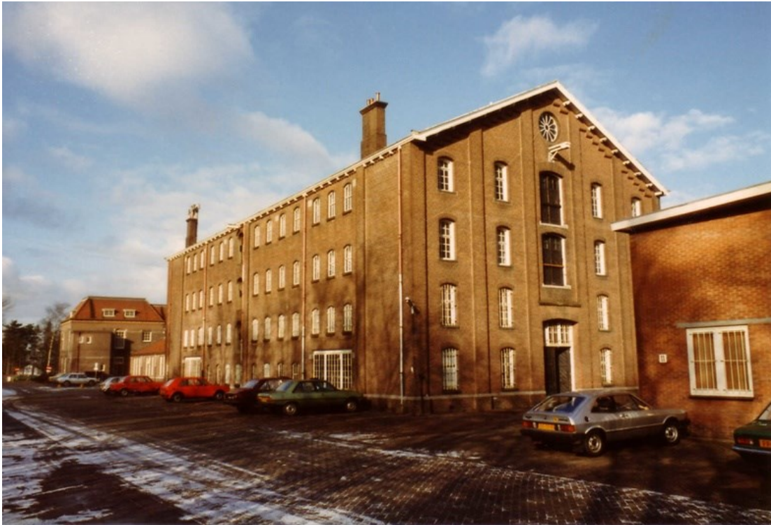
Fig 9. Opname van het rijzige voormalige Arsenaal, direct achter de Frisokazerne. Het gebouw werd in 1989 na een brand gesloopt.
