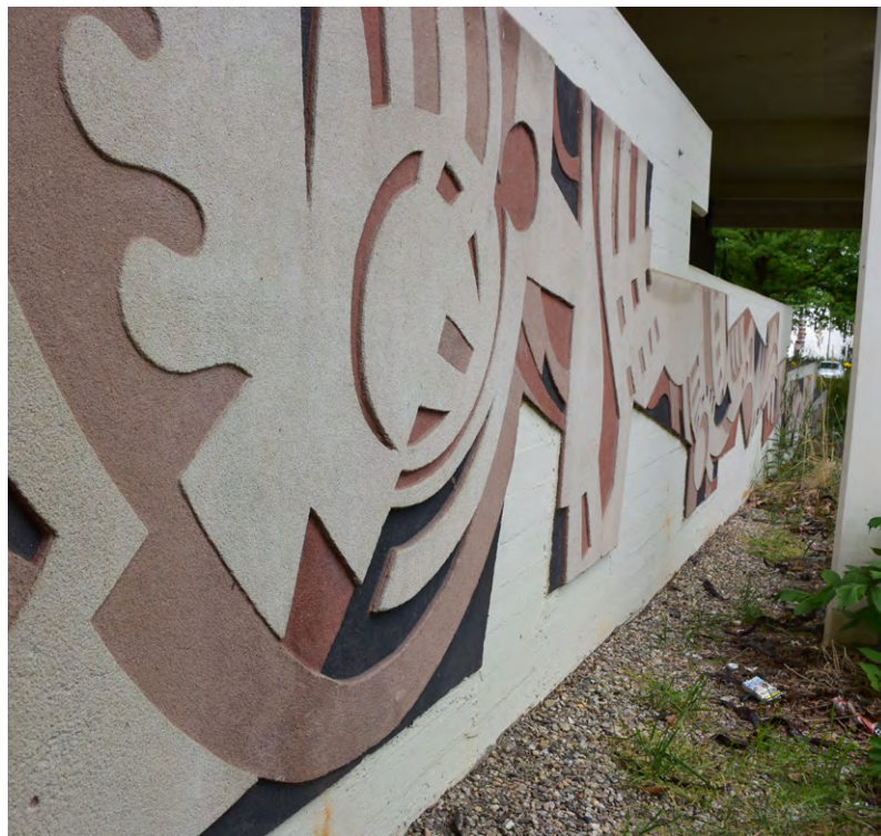
Inpassen van de bestaande graffiti in de nieuwe bebouwing
