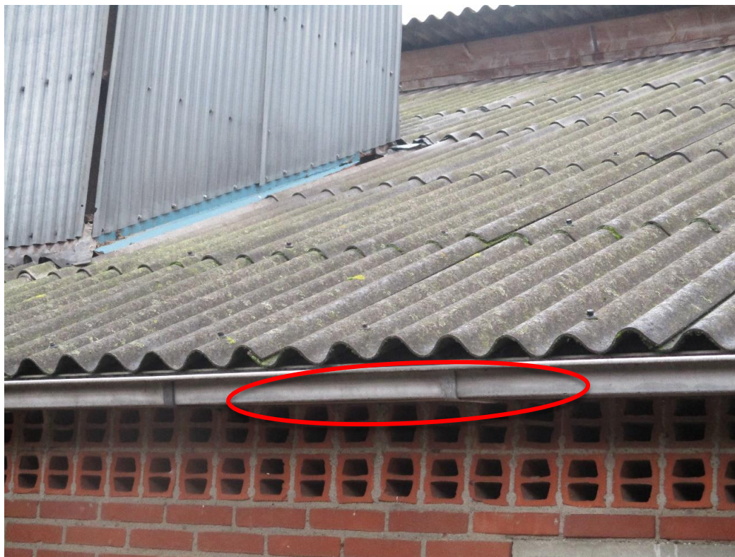
Figuur 2 Aan de onderste rand van de stallen kunnen huismussen toegang krijgen tot de ruimte tussen het dak en de isolatie (rood omcirkeld).
