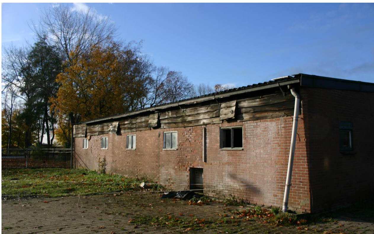
Figuur 4.1.4. De gesloten opslagruimte.
