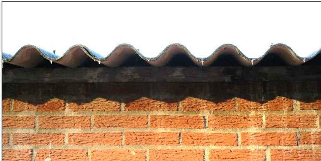
Figuur 4 De dakrand van het golfplaten dak is open, waardoor het dak toegankelijk is voor huismussen. In theorie kunnen hier nesten van huismussen zich bevinden.
