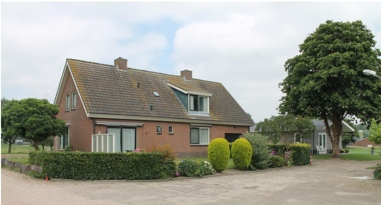
De vernieuwde woning en de mantelwoning
