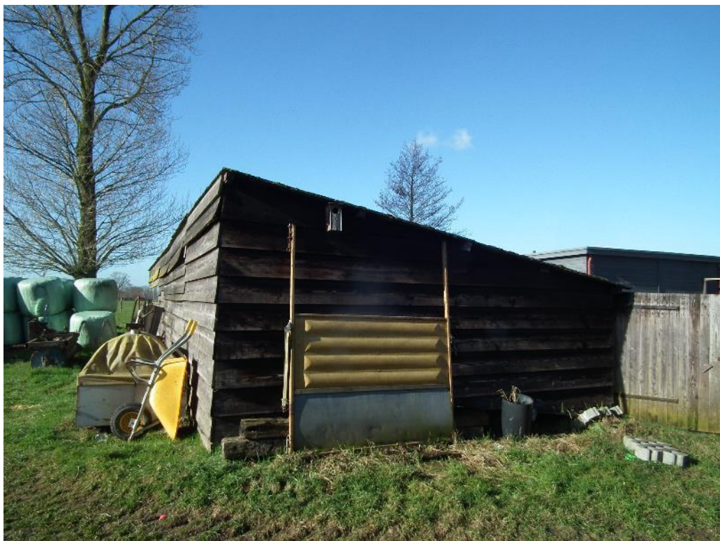
Figuur 4 De schuur waar tevens kippen in gehouden worden is opgetrokken uit houten panelen en een golfplaten dak.
