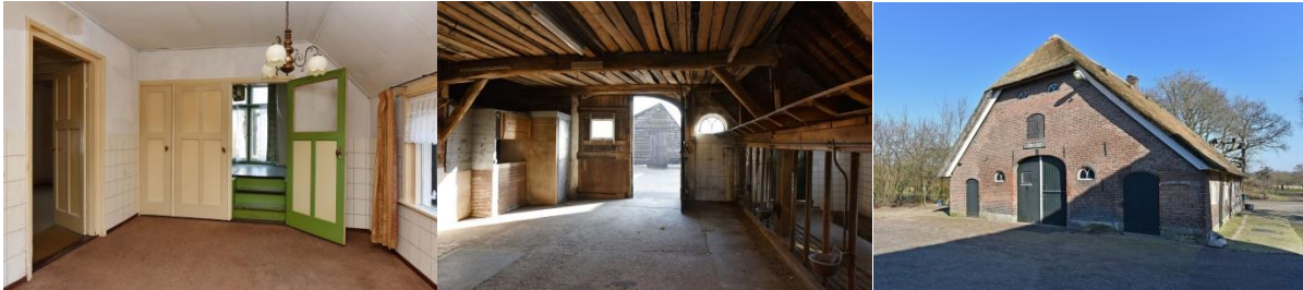
Afb.4: foto's interieur en achtergevel boerderij .
