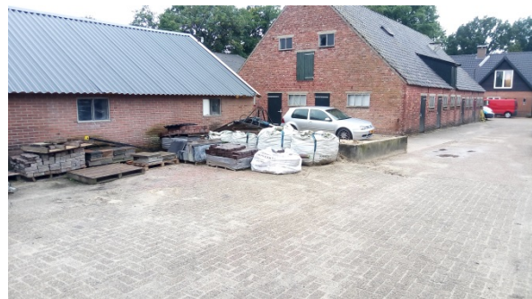
Foto 4: Onderzoekslocatie gezien in zuidwestelijke richting met aan de linker kant schuur 9 en daarachter schuur 8. De dakbedekking van schuur 9 bestaat uit aluminium platen. De dakbedekking van schuur 8 bestaat uit dakpannen.
