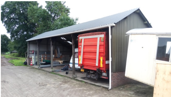
Foto 5: Schuur 10 gezien in zuidoostelijke richting met de toegepaste asbestvrije golfplaten. Aan de kopse kant van deze schuur is een bovengrondse tanks gelegen.
