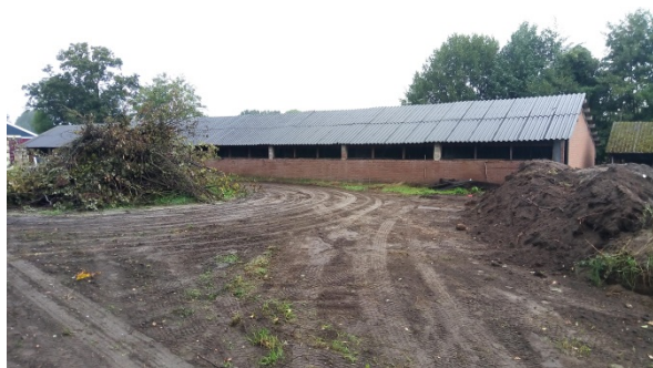
Foto 7: Voormalige stal 5 gezien in noordelijke richting met de toegepaste asbesthoudende golfplaten als dakbedekking. Ter plaatse van deze voormalige stal ontbreekt aan beide zijden een dakgoot.
