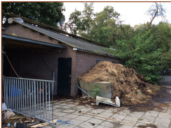
Afb. 2.2: Westelijke schuur vanaf de achterkant van het erf gezien. De weinige openingen in de dakconstructie zijn met gaas dichtgemaakt. Wees tijdens het broedseizoen wel alert op broedvogels die opgaande begroeiing tegen of direct naast het gebouw.
