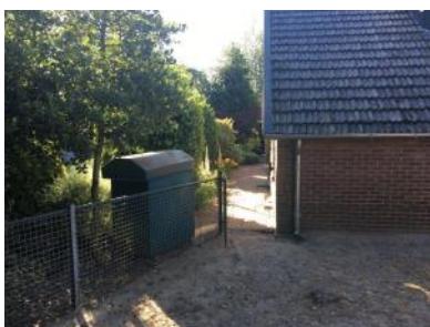
Foto 4: Bovengrondse huisbrandolietank in ijzeren bak
