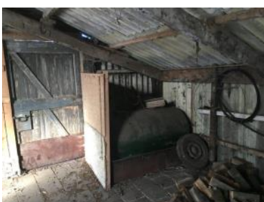
Foto 11: Aanwezige 800 liter bovengrondse dieseltank (schuur 2)
