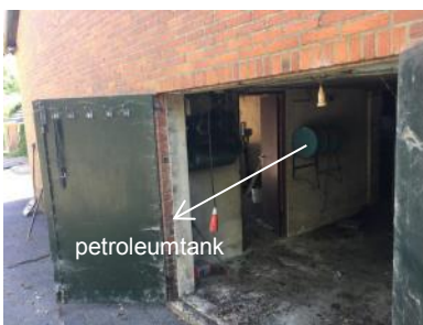
Foto 8: Aanwezige bovengrondse petroleumtank (aan de muur)
