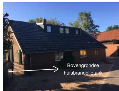
Foto 3: Woonhuis met links de aanwezige bovengrondse huisbrandolietank
