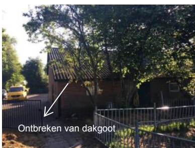
Foto 7: Achterzijde schuur 1 gezien in noordelijke richting met de asbestcementgolflaten (zuidelijke deel) als dakbedekking
