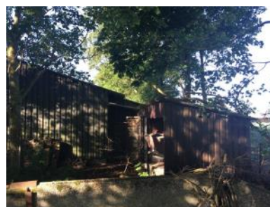
Foto 9: Kopsse kant schuur 2 gezien vanaf de Lage Valkseweg
