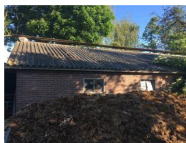
Foto 12: Schuur 3 gezien in westelijke richting met de asbestcement golflaten als dakbedekking
