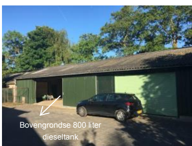
Foto 10: Schuur 2 gezien in westelijke richting met de asbestcementgolflaten als dakbedekking
