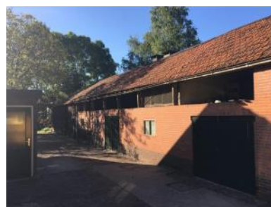
Foto 6: Schuur 1 gezien in zuidelijke richting met aan de voorzijde (noordelijk deel) dakpannen
