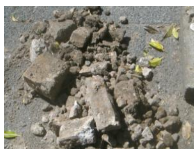
Foto 8: Uitkomend puinhoudend materiaal inspectiegat 4
