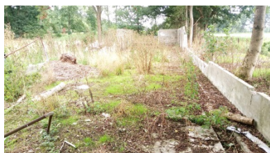
Foto 4: Achterste deel schuur, grotendeels gesloopt
