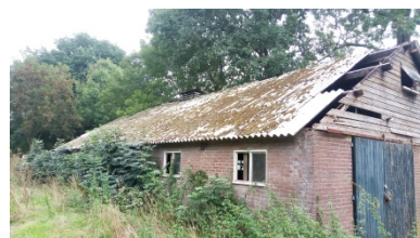
Foto 3: Voorste deel schuur met asbest dakplaten
