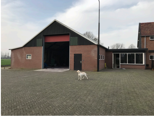
Voor- en zijkant van de te amoveren bebouwing
