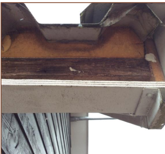
Afb. 2.9 De te slopen kantine. De ruimtes tussen het dakbeschot en de golfplaten zijn afgesloten. Hier is het niet toegankelijk voor vleermuizen en huismussen.
