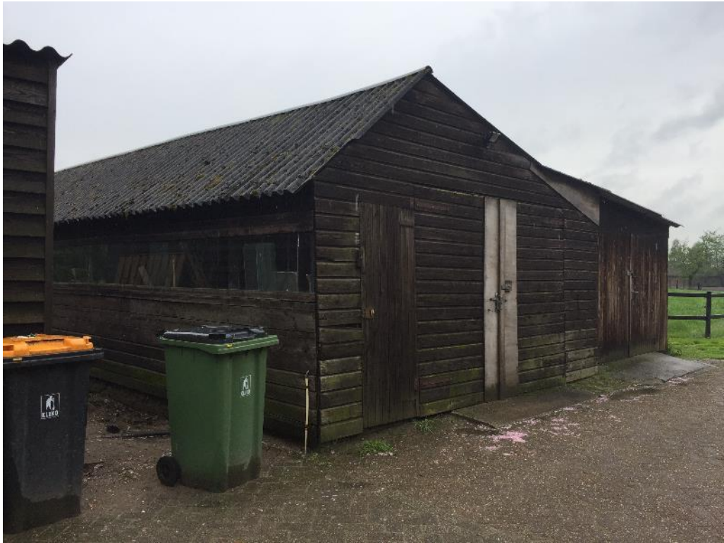
Figuur 3 Een van de andere stallen (westzijde) is opgetrokken uit houten panelen (bovenlaag) en een golfplaten dak.
