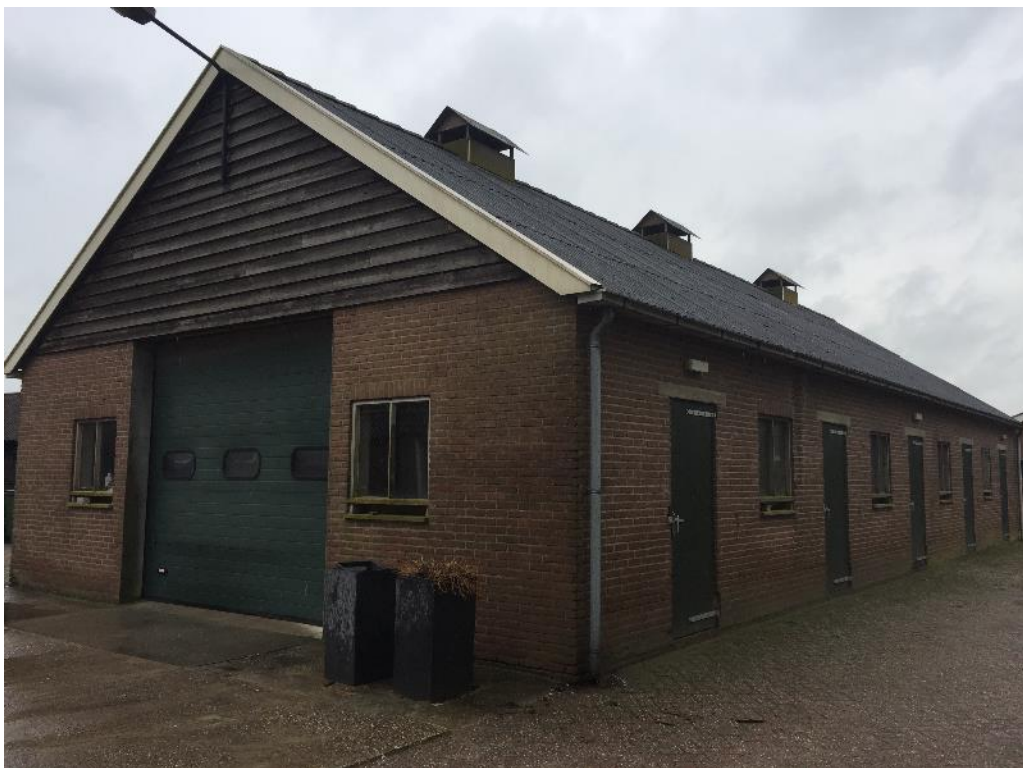
Figuur 2 Een van de stallen is opgetrokken uit gemetselde muren, houten panelen en een golfplaten dak.
