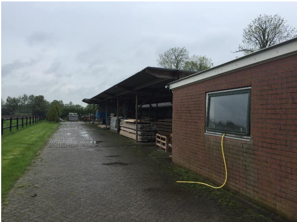
Figuur 4 De noordelijk gelegen (opslag)schuur is enkel opgetrokken uit een houten frame en een dak bestaande uit damwandplaten.
