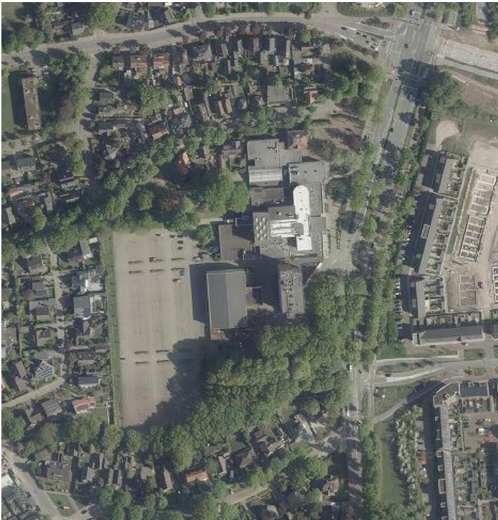
Figuur 1: Luchtfoto plangebied (Bron: www.geo.ede.nl )
