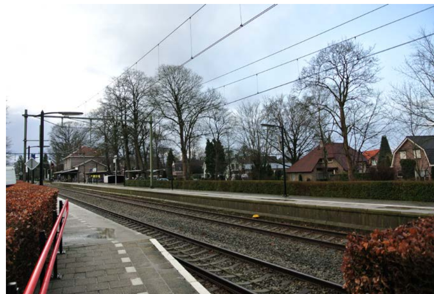
zicht op de spoorstraat vanaf de andere zijde van het spoor
