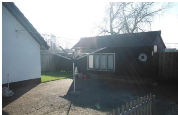
Foto 4: Schuurtje met asbestverdachte golfplaten (circa 20 m 2 )
