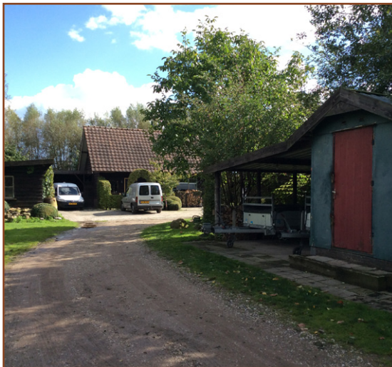
Afb. 2.2: Overzicht van het erf en de te slopen bijgebouwen.
