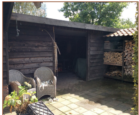
Afb. 2.5: Beeld van de te slopen bijgebouw: golfplaat, ongeïsoleerd, enkelwandig. Gedeeltelijk met stenen onderbouw.
