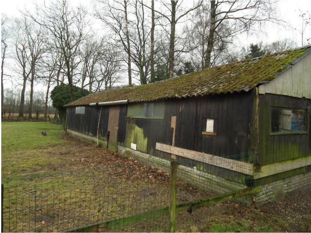
Figuur 3 De gebouwen zijn met, uitzondering van de varkensstal, opgetrokken uit golfplaten en houten panelen. De varkensstal bestaat uit gemetselde muren en een golfplaten dak.
