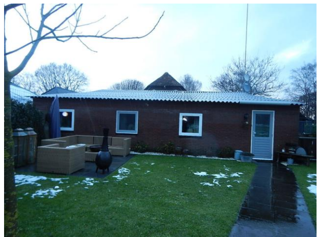
Bron 3 golfplaten dak (achterzijde) schuur 2 niet asbesthoudend (2)
