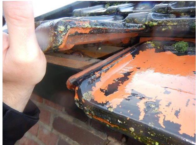
Geen dakbeschoot aanwezig op schuur 3
