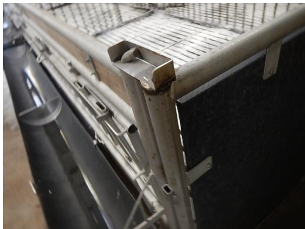
Tussenschotten schuur 1 niet asbestverdacht
