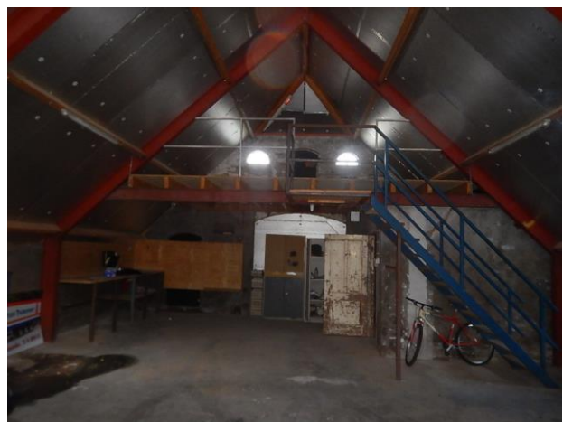
Overzicht binnenzijde schuur 3
