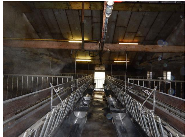
Binnenzijde dak schuur 1 is afgeschermd
