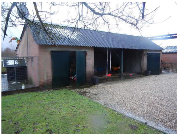
Bron 4 golfplaten dak (voorzijde) schuur 2
