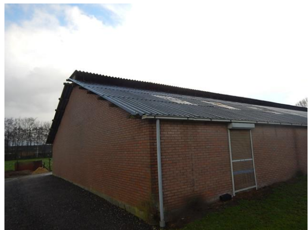
Bron 2 golfplaten dak (achterzijde) schuur 1 niet asbesthoudend (2)
