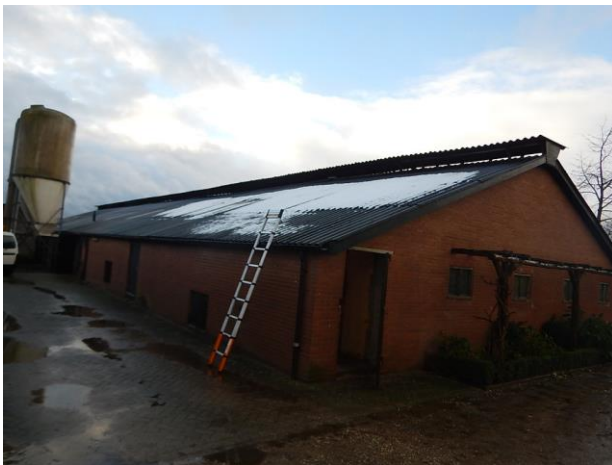
Bron 1 golfplaten dak (voorzijde) schuur 1
