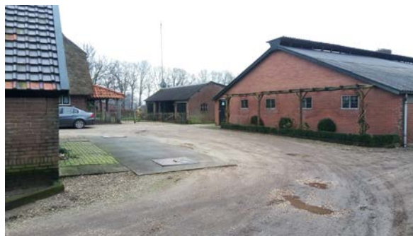
Foto 2: Onderzoekslocatie met links de hoek van schuur 1 en rechts de kalverenstal.
