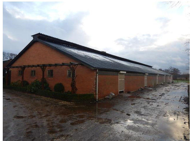
Bron 1 golfplaten dak (voorzijde) schuur 1 (2)
