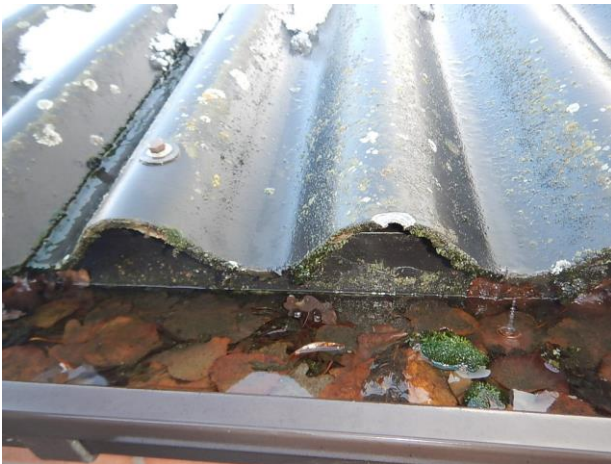
Bron 1 golfplaten dak (voorzijde) schuur 1 detail
