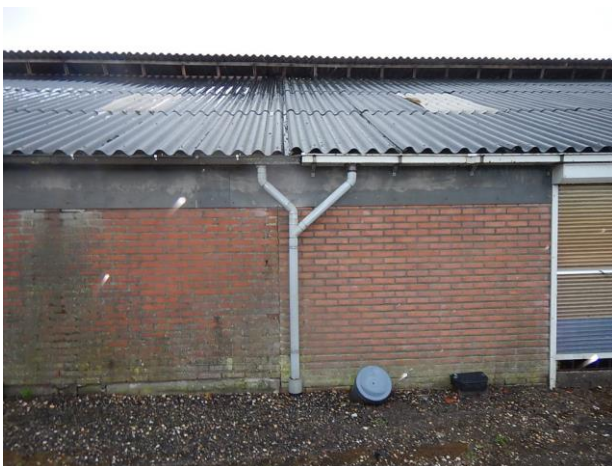
Bron 2 golfplaten dak (achterzijde) schuur 1 niet asbesthoudend (3)
