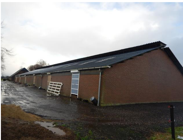
Bron 2 golfplaten dak (achterzijde) schuur 1 niet asbesthoudend
