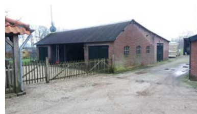
Foto 5: De aanwezige schuur 3 met aan de achterzijde de woning gezien in zuidoostelijke richting.
