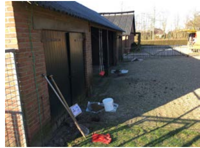
Foto 8: Strook met asbestinspectiegaten voorzijde schuur 3.
