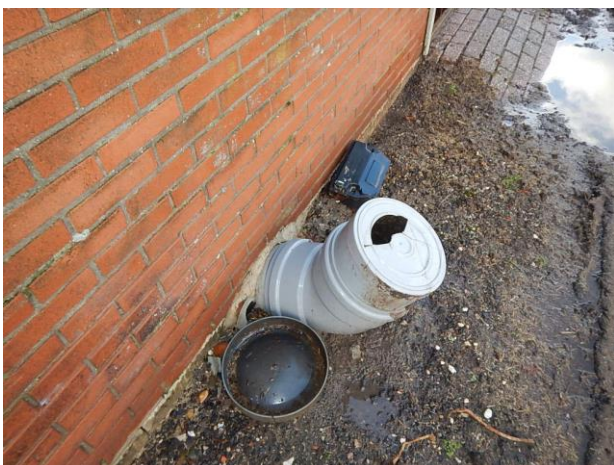
Schuur 1 doorvoeren van pvc
