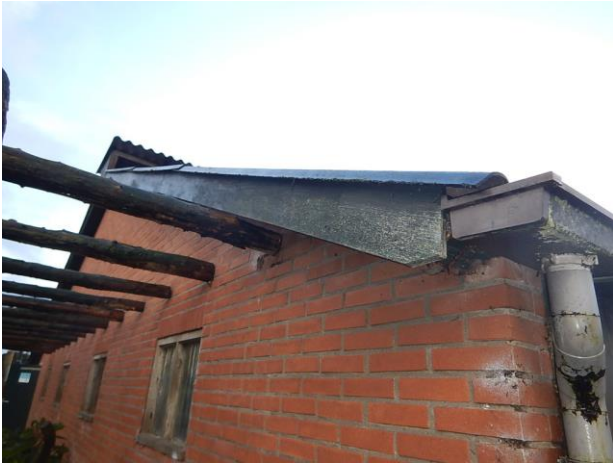
Afwerking schuur 1 van hout
