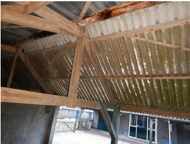
Bron 4 golfplaten dak (voorzijde) schuur 2 (3)
