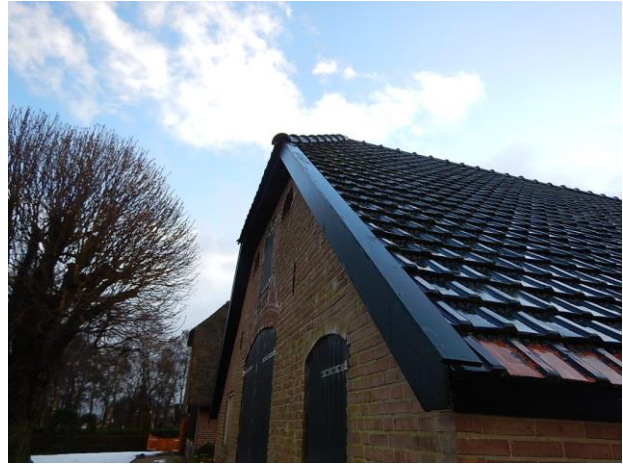
Afwerking schuur 3 van hout
