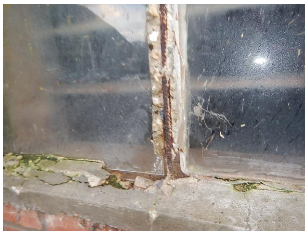
Schuur 1 geen asbestverdachte beglazingskit
