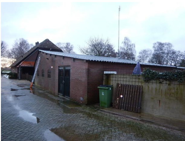
Bron 3 golfplaten dak (achterzijde) schuur 2 niet asbesthoudend
