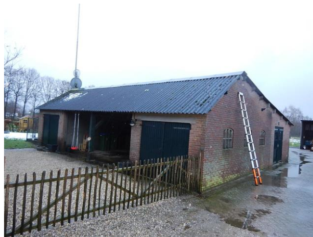
Bron 4 golfplaten dak (voorzijde) schuur 2 (2)
