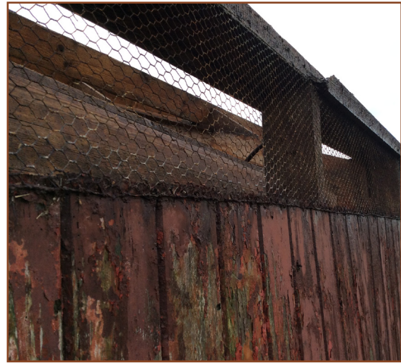
Afb. 2.2: Gaas aangebracht bij luchtopeningen van stal A. Alle nu nog aanwezige openingen zijn zeer secuur ontoegankelijk gemaakt, wat doet vermoeden dat ook de dakconstructie niet toegankelijk was voor vogels, marters en vleermuizen. Het is echter niet mogelijk dit met zekerheid te zeggen.
