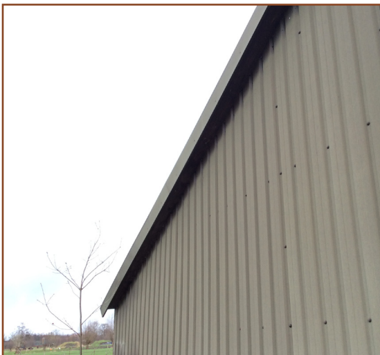
Afb. 2.3: Detail westgevel stal A. De profielplaten sluiten strak aan op de daklijst.
