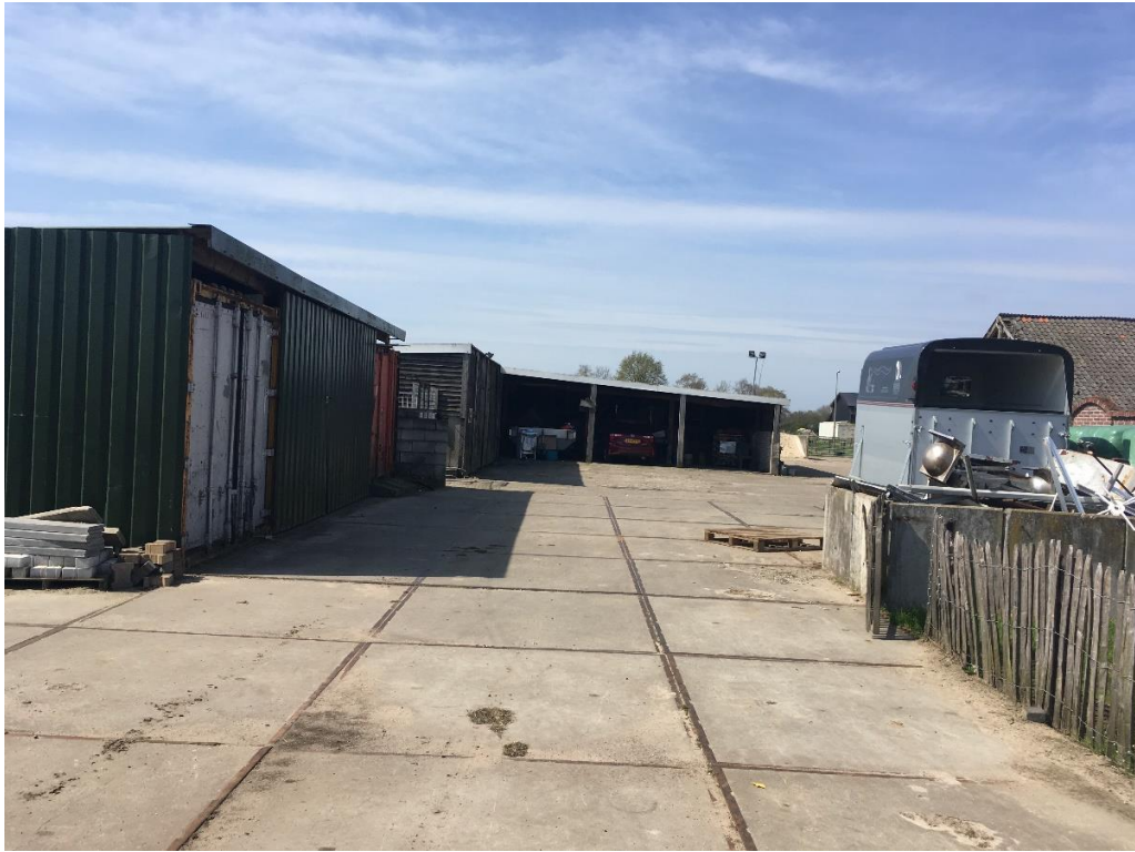
Figuur 3 De locatie is met name verhard met betonplaten en straatstenen. De te verwijderen bebouwing betreft onder andere een zeecontainer en carport.
