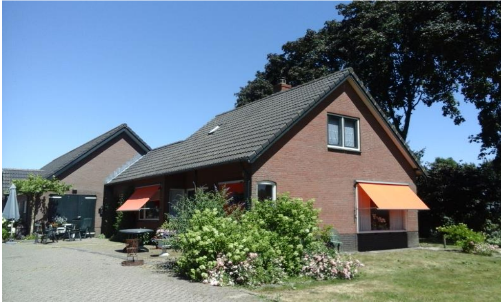
Figuur 1 De planlocatie is gelegen aan de Binnenweg 9 te De Klomp en betreft een woning met een tweetal veestallen.
