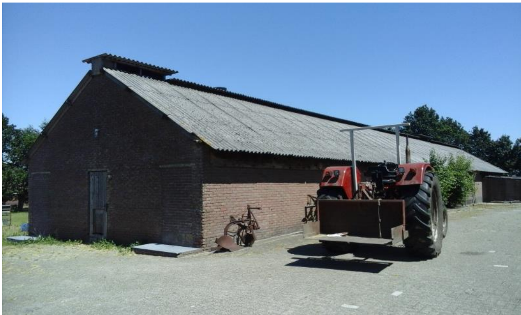
Figuur 2 Een van de veestallen is opgetrokken uit gemetselde muren, houten panelen onder het dak en een golfplaten dak. Tevens is er aan de noordzijde een aanbouw bestaande uit houten panelen aanwezig.
