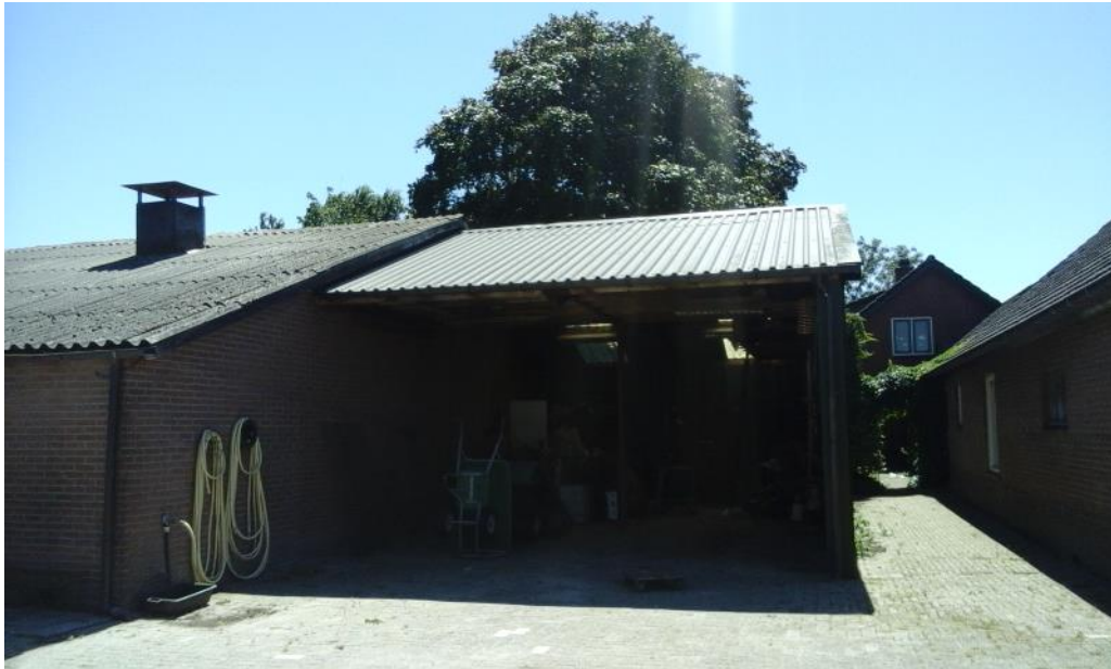
Figuur 3 De andere veestal (links) met aanbouw, welke is opgetrokken uit een damwand, gemetselde muur en een golfplaten dak.
