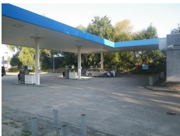
Foto 3: De luifel boven een vloestofdichte vloer met afleverzuilen
