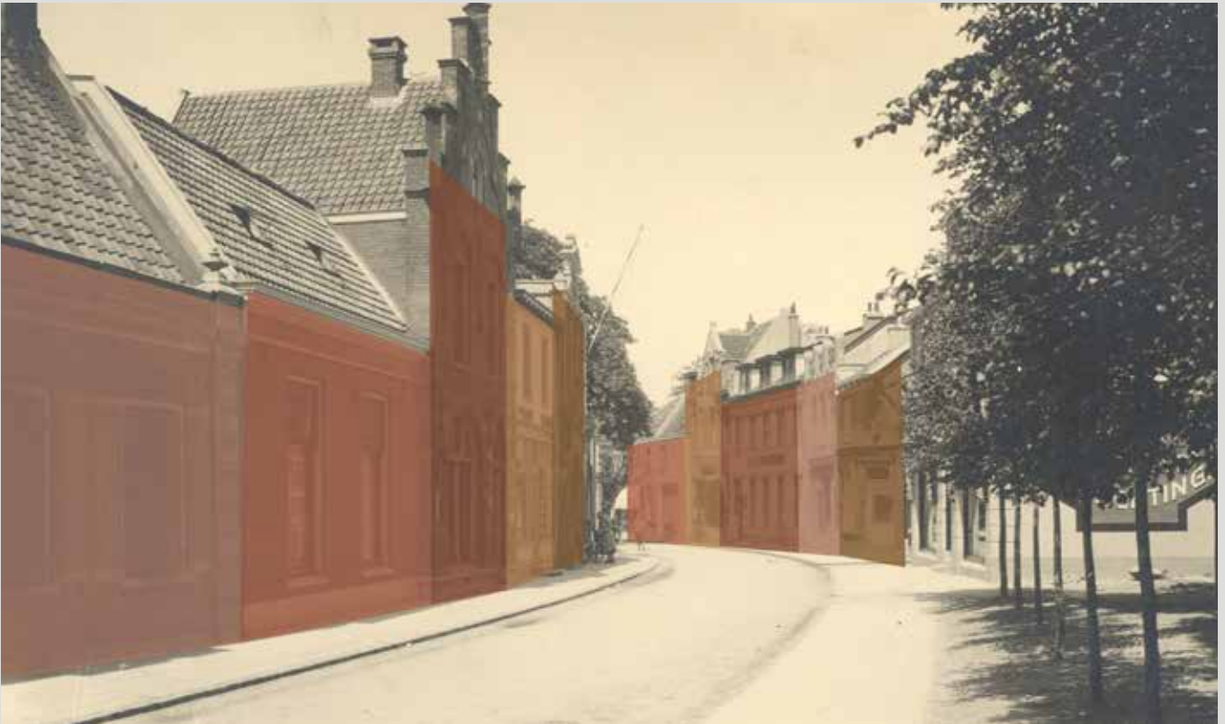
Renoveren van mogelijke historische en beeldbepalende gevels.
