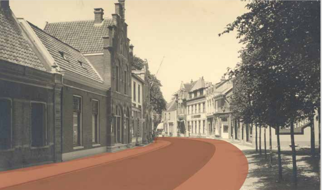
Het historische straatprofiel bestaande uit een rijweg met trottoirs.
