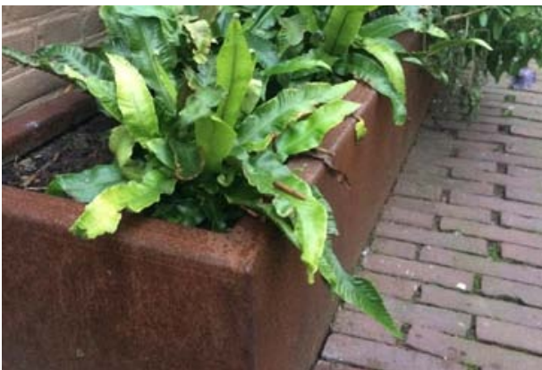
Cortenstalen plantenbak als geveltuintje
