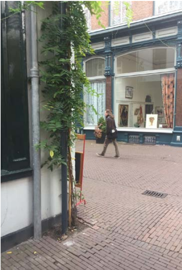
Gevelgroen aan paal met klimbegeleiding
