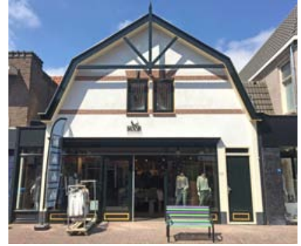
Na gevelverbetering (Maandereind 36)
