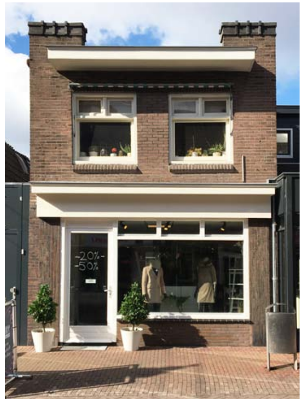
Na gevelverbetering (Maandereind 38)
