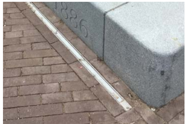
Subtiele verlichting opgenomen in straatwerk
