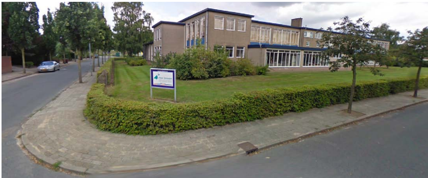
schoolgebouw met versprongen hoeken, haag en groene 'plint'
