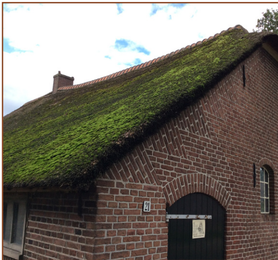
Afb. 2.2: Detail van de achtergevel van de boerderij. Openingen en holten ontbreken.
