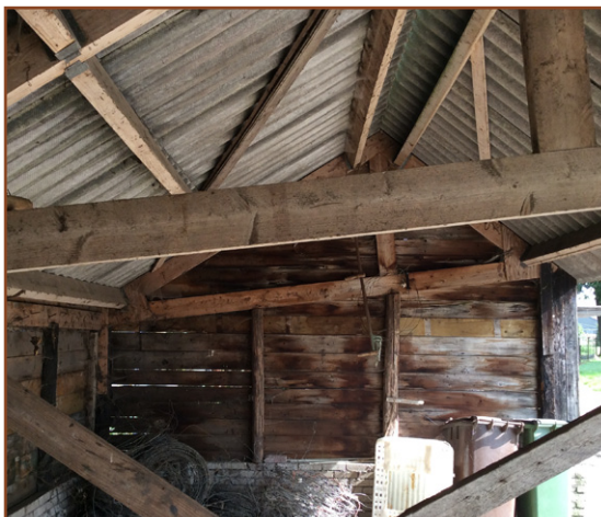
Afb. 2.9: De houten schuur, enkelwandig, open en zonder spouw of verdere aftimmering.
