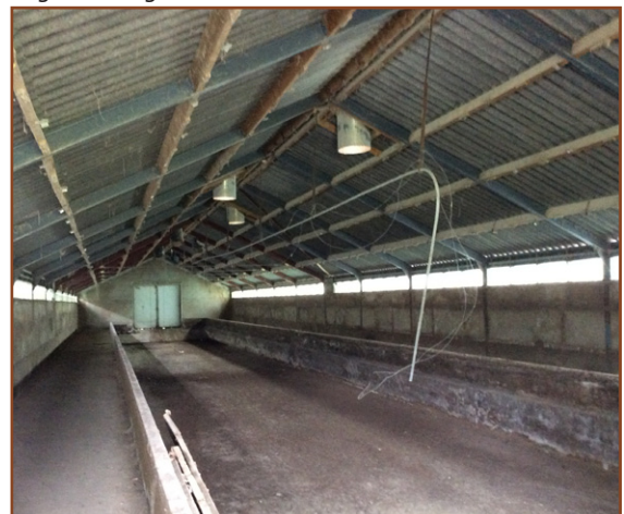
Afb. 2.10: Varkensschuur, enkelwandig, geen aftimmering.
