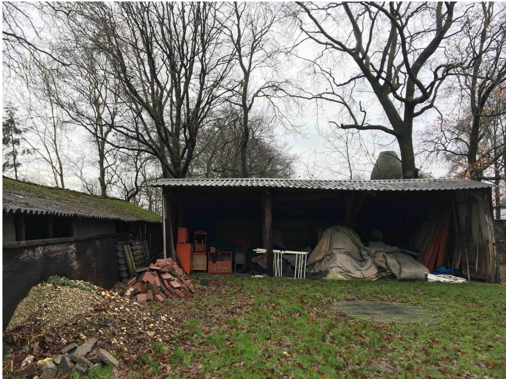
Figuur 3 De halfopen overkapping behorende bij schuur E wordt gesloopt in het derde van de sloopmeterregeling.
