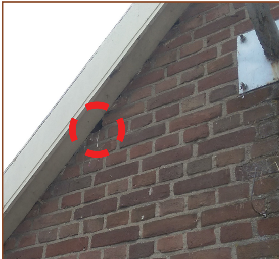
Afb. 3.3: Mogelijke nestlocatie Huismus. Bij de kopgevels bevinden zich diverse soortgelijke openingen.
