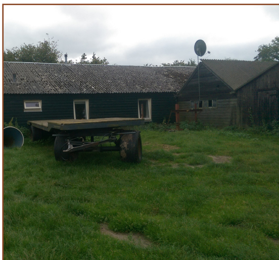
Afb. 3.5: Aanblik noordoostelijke hoek terrein met verschillende houten opstallen.
