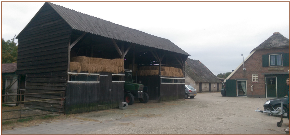
Afb. 3.2: Erf vanuit oostelijke richting gezien. Links de houten kapschuur, rechts de woonboerderij. In het midden is een deel van een voormalige varkensstal te zien.
