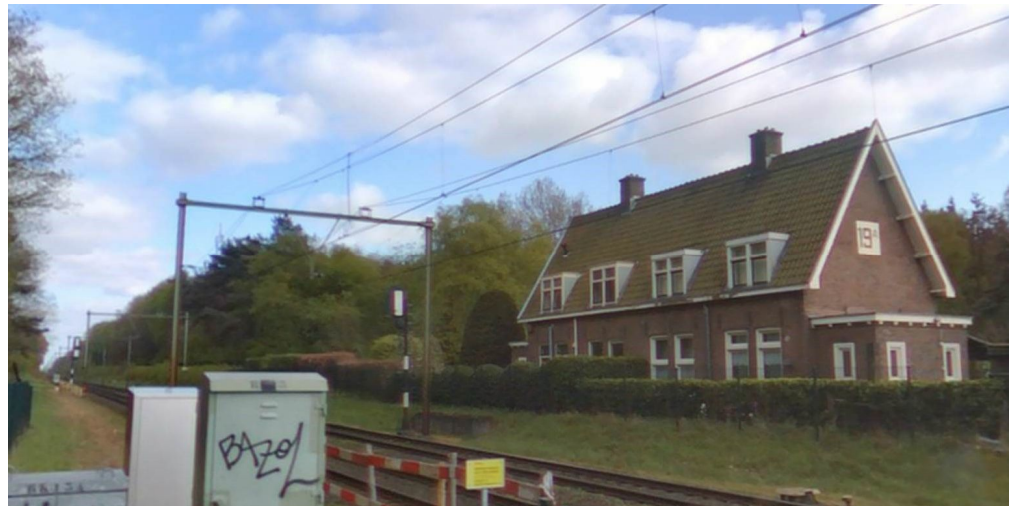
Figuur 6 Ligging van de saneringswoningen aan de Dr. Hartogsweg 5 en 7 t.o.v. het spoor (bron: Cyclomedia).
