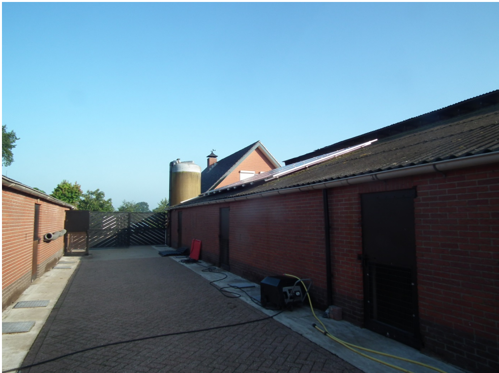
Figuur 2 De planlocatie bestaat voornamelijk uit goed onderhouden tuin en verharding, met een woning en varkensschuren.
