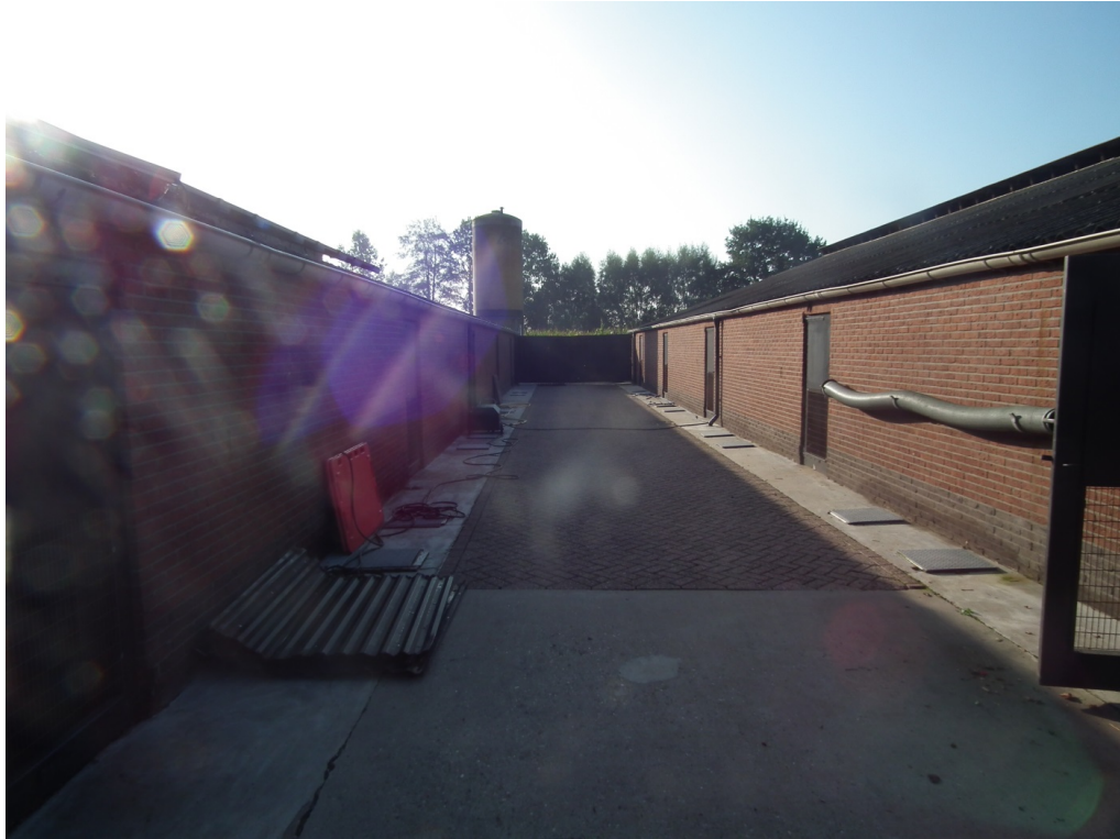
Figuur 3 De initiatiefnemer is voornemens de twee varkensschuren te slopen zonder er nieuwe bebouwing voor terug te zetten.
