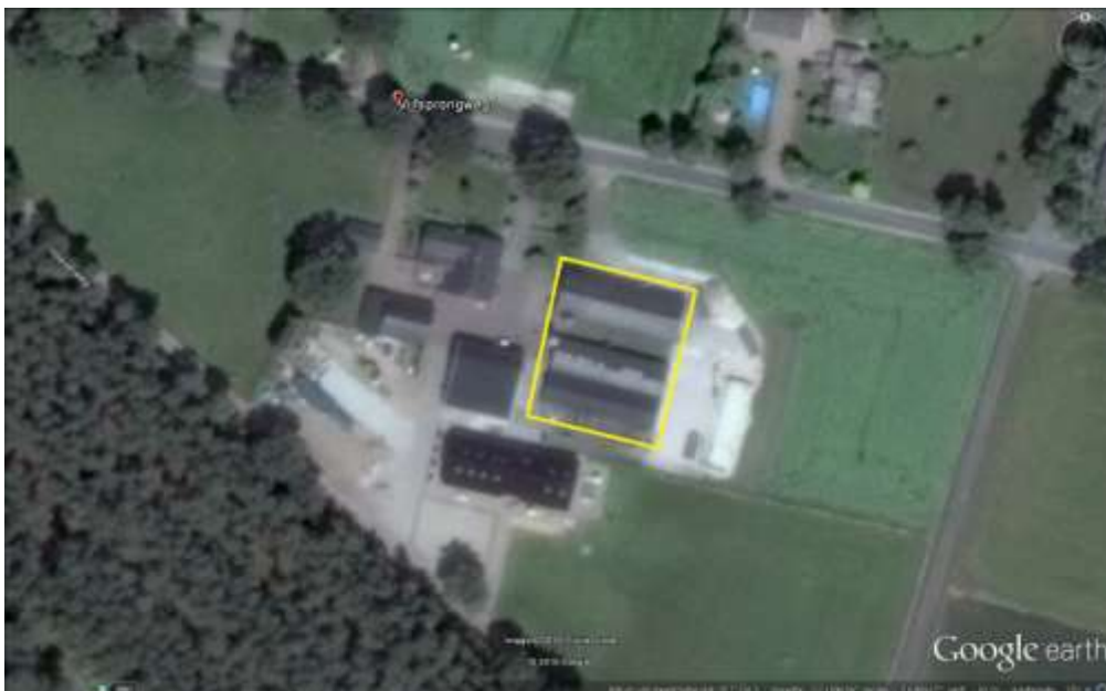
Figuur 1.1: Ligging van de te slopen gebouwen (geel omlijnd). Bron luchtfoto: Google Earth.
