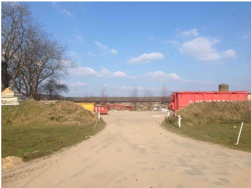
Figuur 4 Een deel van het terrein is in gebruik als buitenopslag van allerhande (bouw)materialen en materieel
