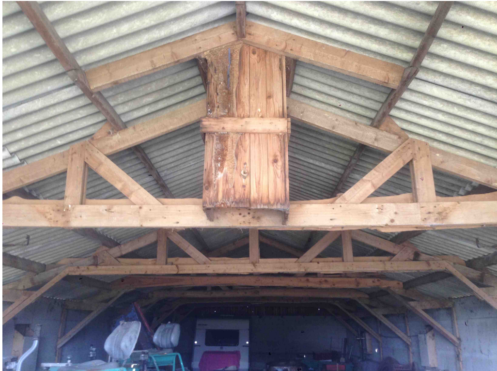
Figuur 3 De daken en muren van de te slopen schuren zijn niet geïsoleerd waardoor er geen sprake is van een stabiel microklimaat.
