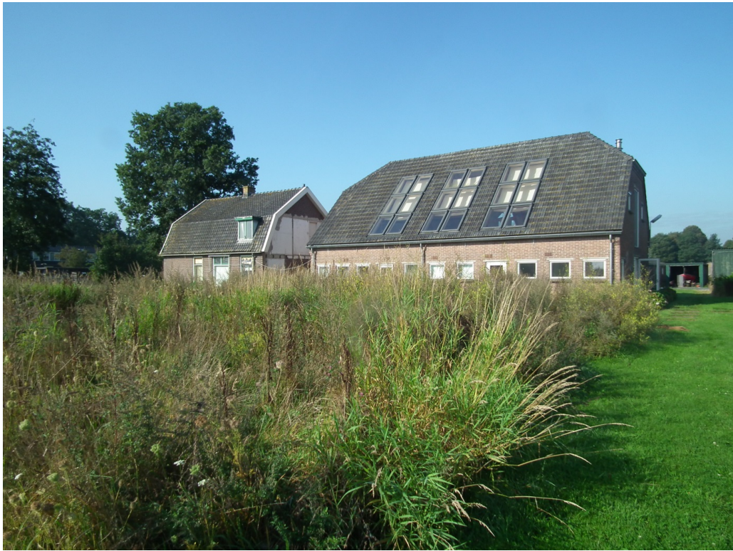
Figuur 1 De planlocatie is gelegen in het buitengebied van het dorp Ederveen. Gelegen aan de Rijksweg tussen Ede, Veenendaal en Ederveen.
