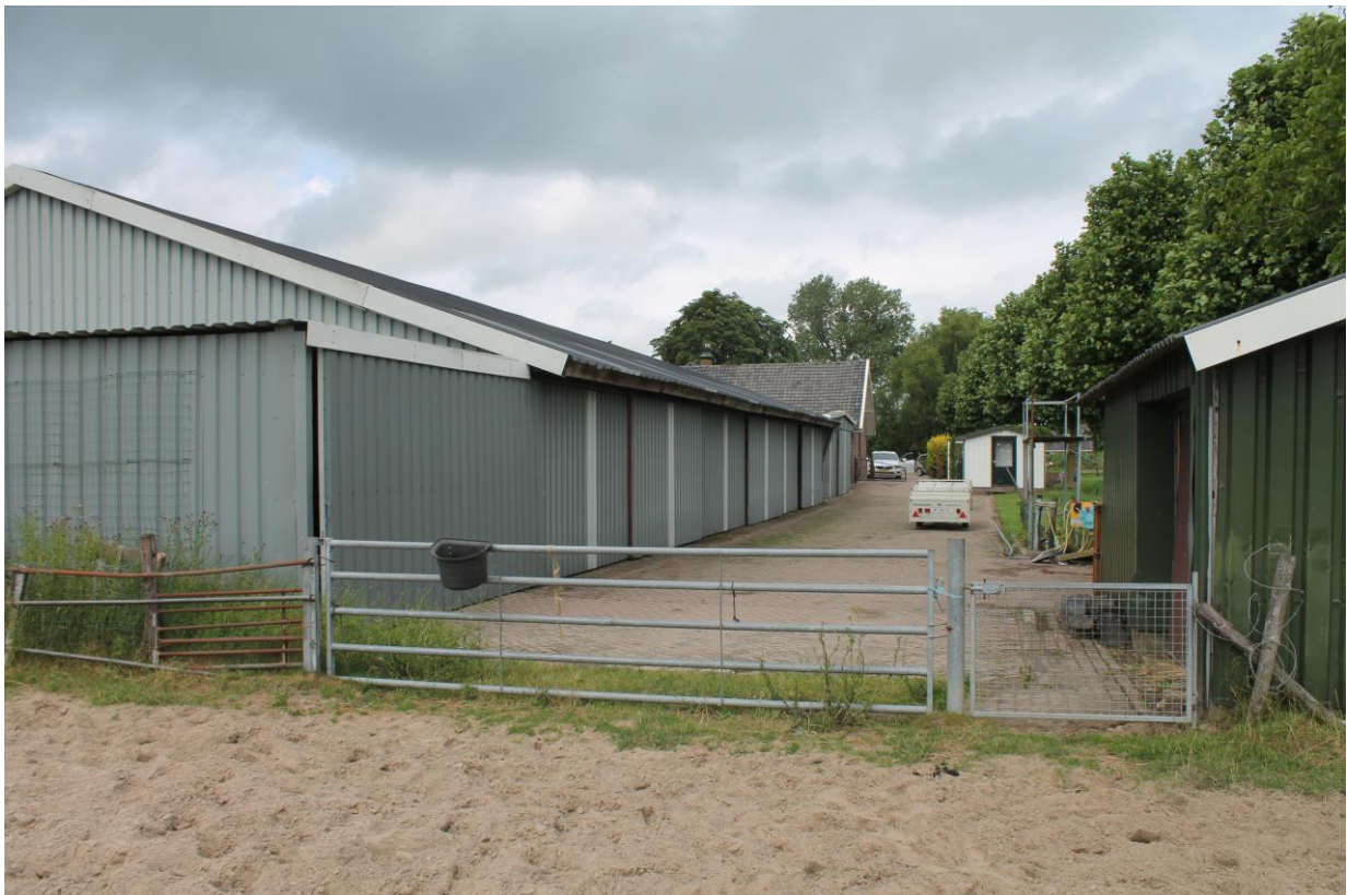
SCHUREN MET DAKEN EN WANDEN VAN METALEN GOLFPLATEN ALLE SCHUREN WORDEN GESLOOPT EN DE VERHARDING WORDT OPPERUIMD
