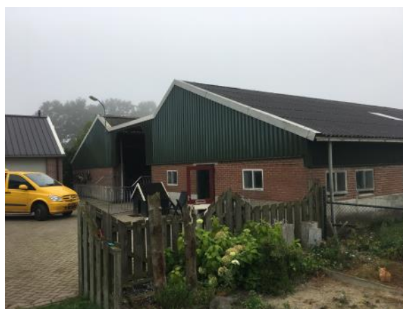
Foto 2: Onderzochte locatie (stalling voor caravans en campers)
