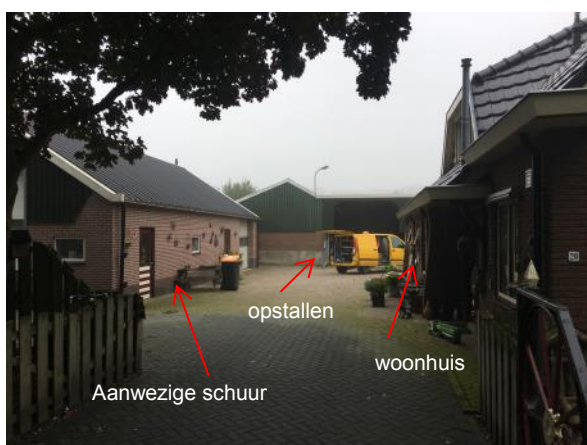
Foto 1: Oprit vanaf de Braeckweg met zicht op de aanwezige bebouwing
