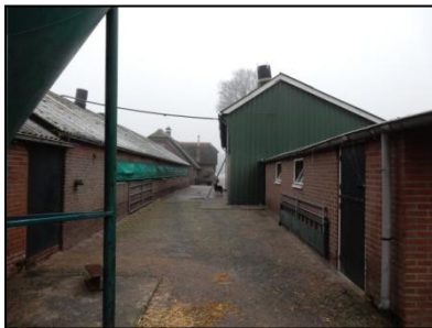
Figuur 3. Kalverstal (links) en voormalige stallen (rechts).
