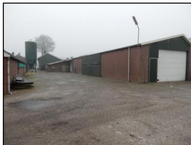
Figuur 7. Voormalige veestal, thans stallingsruimte.
