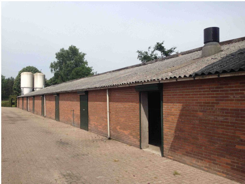
Figuur 1 De planlocatie is gelegen aan Hoeverweg 4 te Wekerom. De beoogde ingreep bestaat uit de sloop van twee kalverenschuren.
