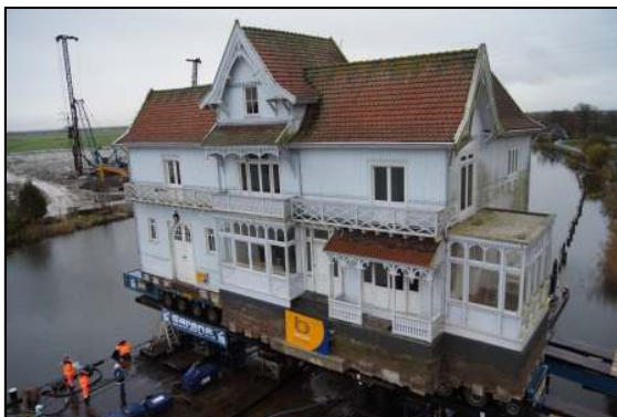
Afbeelding 23: Verplaatsing in 2013 van de monumentale Vechthoeve (1899) nabij Muiden. De hoeve moest wijken voor de aanleg van de A1. Rijkswaterstaat verbreedt in dit gebied de komende jaren de drukke snelwegen tussen Schiphol, Amsterdam en Almere met één of meer rijstroken.
