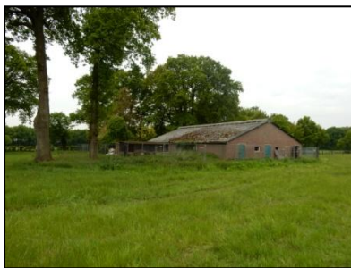
Figuur 3. stal op onderzoekslocatie.
