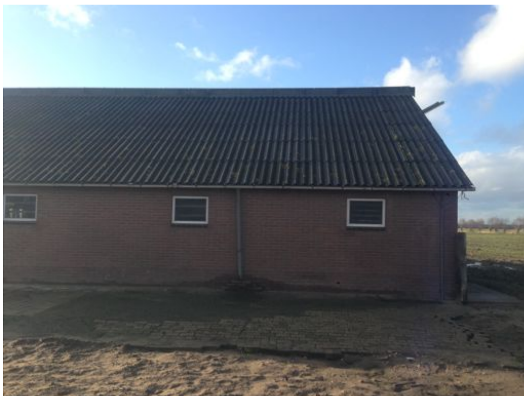
Figuur 2 De stal bestaat uit steense muren en een golfplaten dak. Het dak is aan de binnenzijde geïsoleerd met isolatieplaten (zie tevens foto 3).
