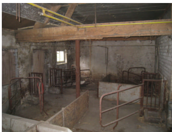
Foto 2: te slopen voormalige varkensstal
