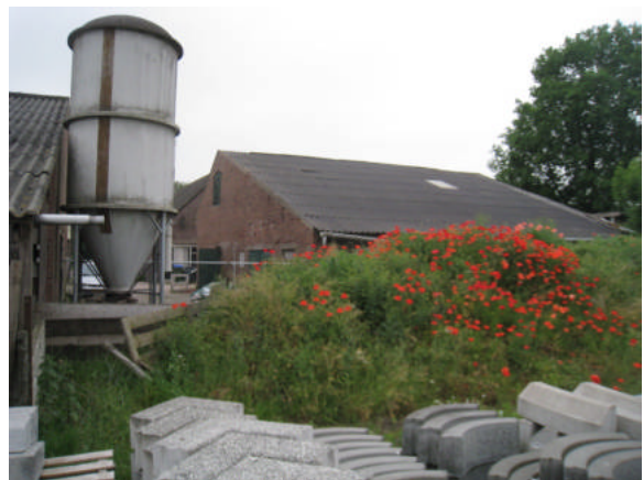
Foto 6: te slopen schuur achter nr 1
