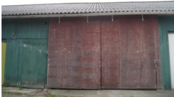
Foto 3: te slopen schuur achter nr 3
