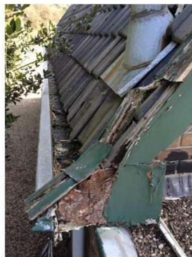
6. Ruimte tussen boeideel en buitenmuur.
