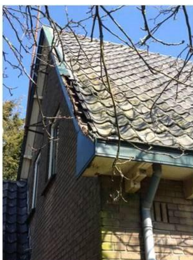
2. Windveer kapot, open voegen t.b.v. binnen-ventilatie.
