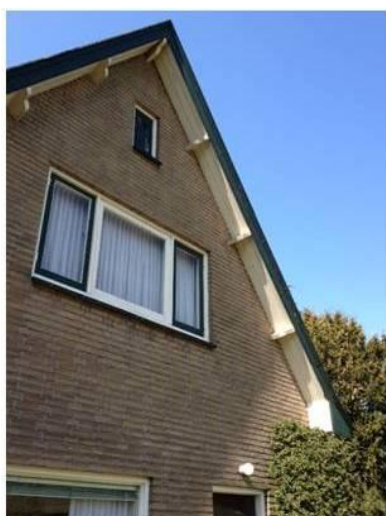
1. Geen open stootvoegen t.b.v. spouwventilatie.
