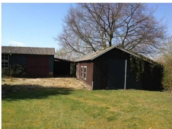
9. Houten schuren, enkelwandige wanden en daken.
