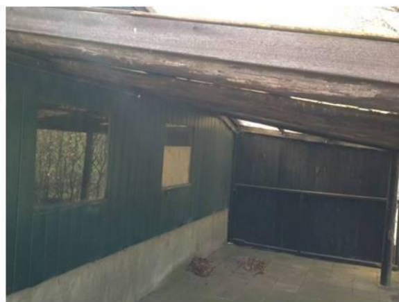
10. Overkapping, geen sporen aangetroffen.
