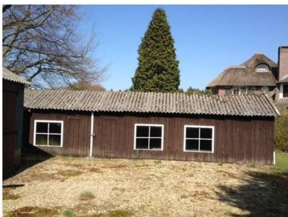
7. Houten schuren, enkelwandige wanden en daken.
