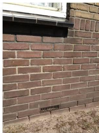
3. Ventilatie kruipruimte d.m.v. muurrooster.
