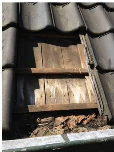
4. Geen sporen onder de dakpannen.
