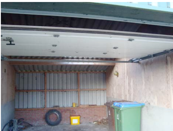
Foto 5. Te slopen gebouw 4
