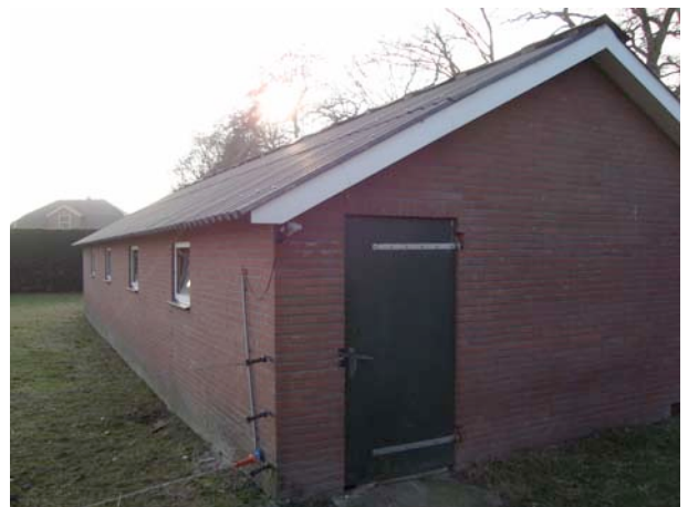
Foto 6. Mogelijk te slopen gebouw 6
