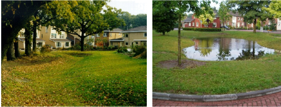
Figuur 7 Voorbeelden infiltratiebassins
