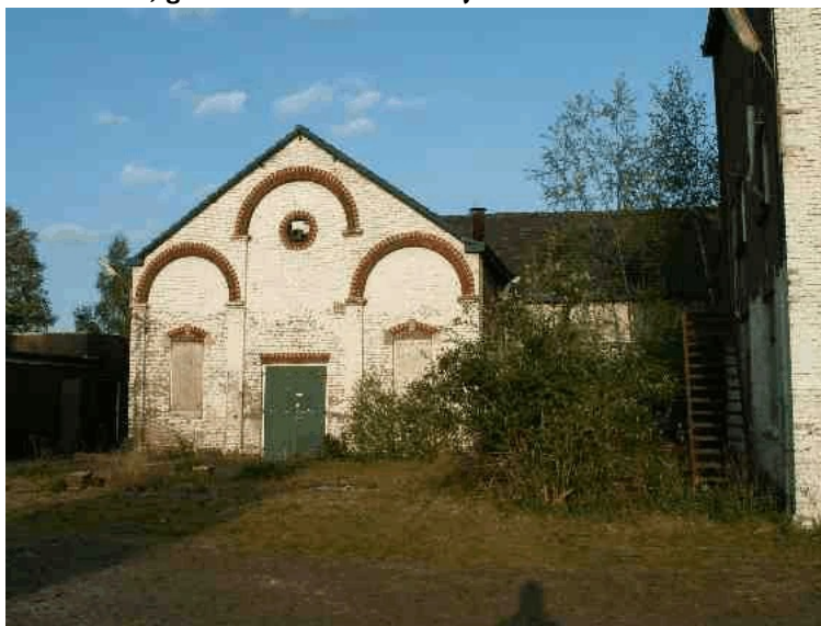
Gebouw C, gezien vanaf de oostzijde
