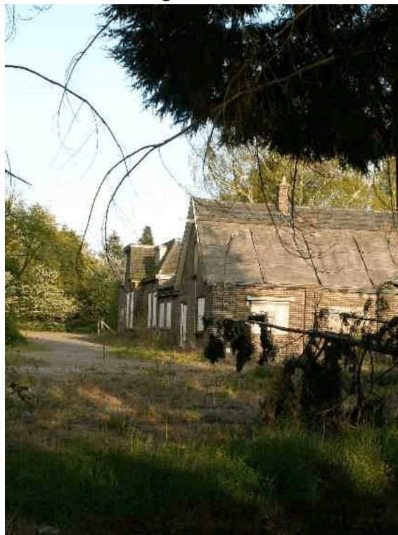
Deel van de vliegroute van Gewone dwergvleermuis, tussen gebouwen B en C door
